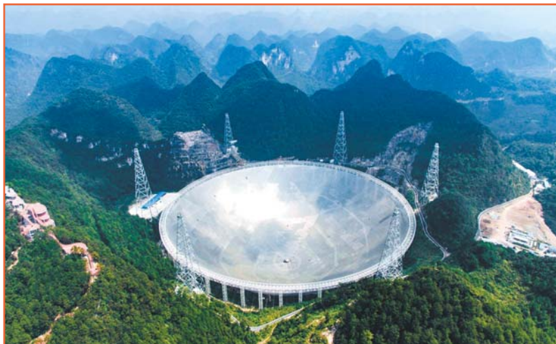
Крупный радиотелескоп с диаметром сплошного зеркала 500 м, построенный в Китае
